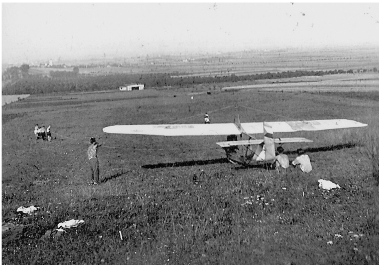
Kluzák Skaut startuje pomocí gumového lana; Podhořany-Bumbálka, květen 1946
