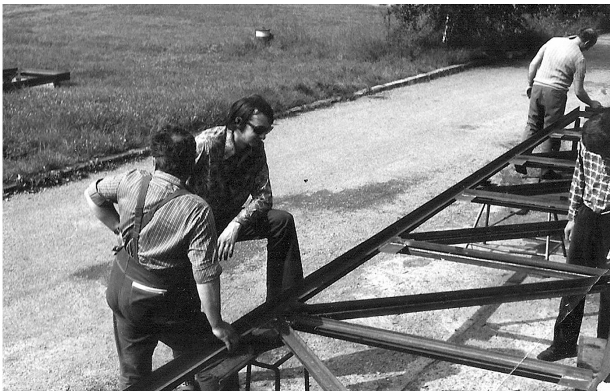
Příprava ocelové konstrukce prodloužení „dřevěného“ hangáru, zleva: Josef Vojtíšek, Jiří Pilný, Josef Křištof, Milan Eiselt; Nový Dvůr, září 1974
