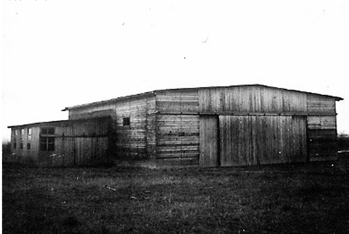
Hangár s dílnou u silnice Podhořany – Semtěš; konec dubna 1946.
