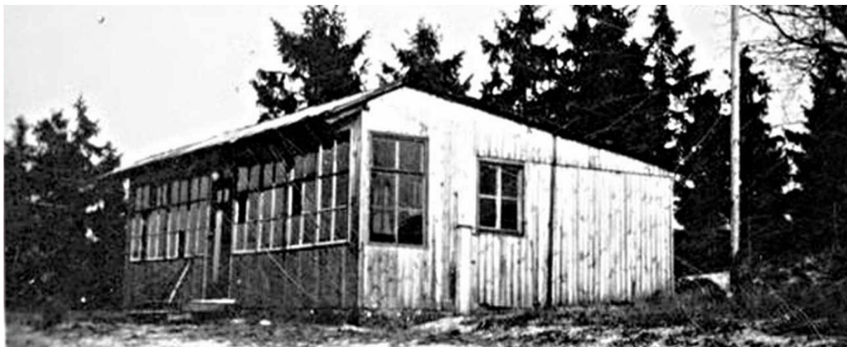
Jako první je na svahu u Bumbálky postaven „pavilonek“; Podhořany-Bumbálka, březen 1946
