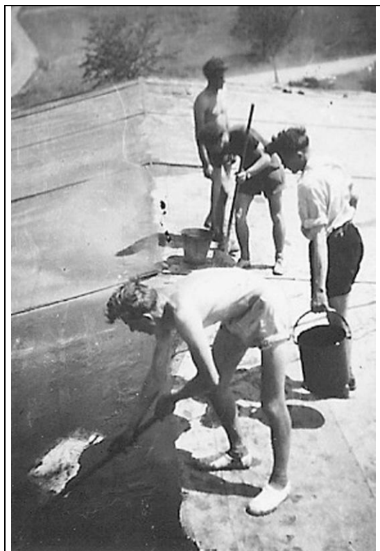
Asfaltování střechy; Nový Dvůr, září 1949
