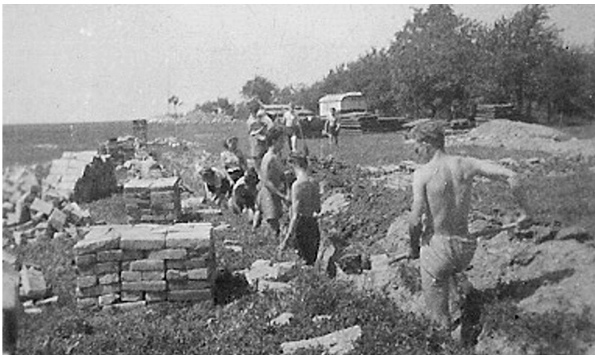
Výkop základů pro hangár na Novém Dvoře; srpen 1949
