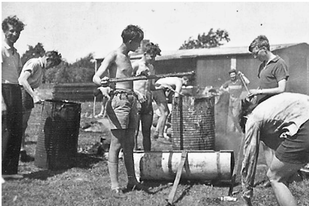
Asfaltování střechy hangáru na Novém Dvoře; září 1949
